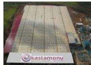
Административный корпус завода по производству панелей МДФ Kastamonu Entegre A.S. (Елабуга)
